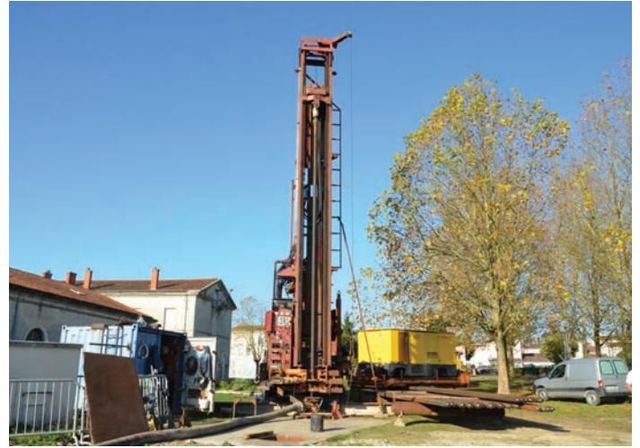
Nettoyage du forage - Novembre 2015
