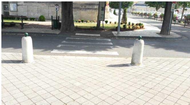
Traversée de voie sans bande podotactile d'un côté
