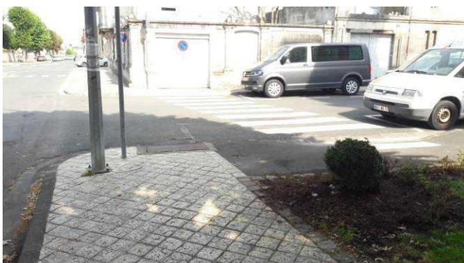
Traversée de voie sans bande podotactile d'un côté
