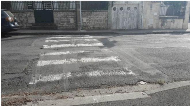
Traversée de voie sans abaissé d'un côté ni bandes podotactiles, face à un poteau électrique gênant l'accès à la pharmacie pour une personne en fauteuil
