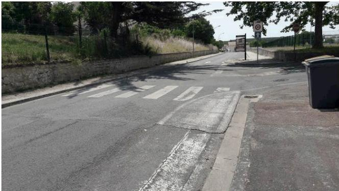
Traversée de voie avec grilles à fentes > à 2 cm de large, sans abaissé de trottoir sur un côté ni bandes podotactiles
