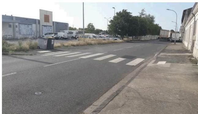
Traversée de voie bloquée par obstacles temporaires, bandes podotactiles ne faisant pas la largeur de la traversée, cheminement principal bloqué également par véhicule (poursuite du cheminement accessible sur le même côté)
