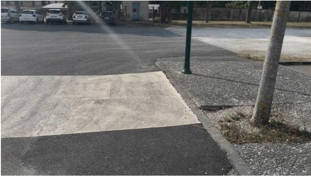
Présence d'un ressaut à la jonction enrobé/béton désactivé
