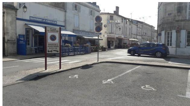
Places PMR de largeur < à 3.30 ml, non raccordée aisément au cheminement
