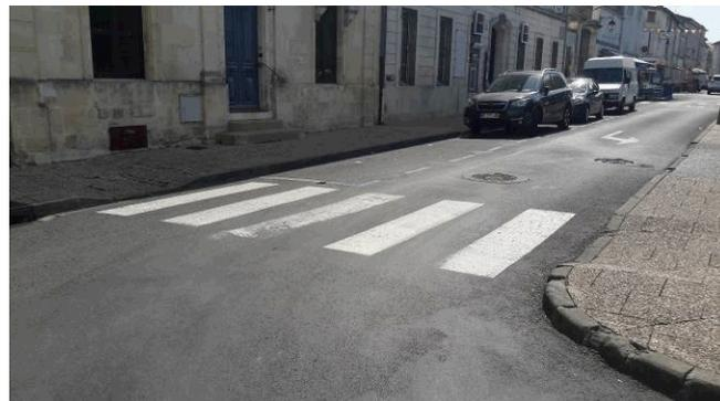
Idem avec abaissé insuffisant d'un côté (ressaut > à 2 cm)
