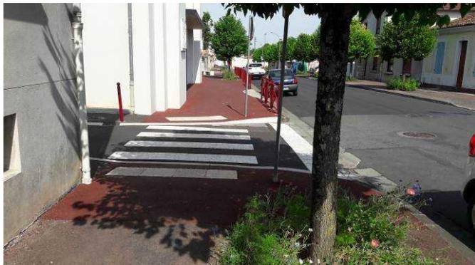
bande podotactile non parallèle à la traversée, sans guide tactile
