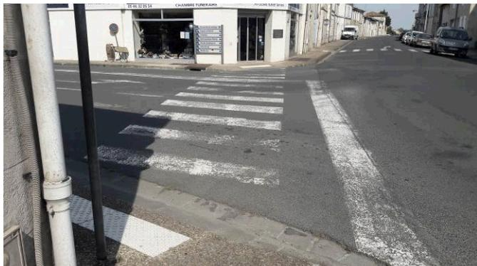
Réduction du cheminement à moins de 90 cm de large, bandes podotactiles non parallèle à la traversée de voie sans guide tactile
