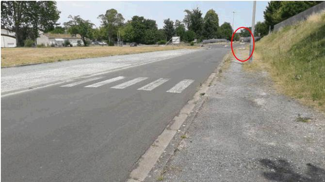
traversée de voie sans abaissé d'un côté ni bandes podotactiles, un panneau bloquant sur le cheminement
