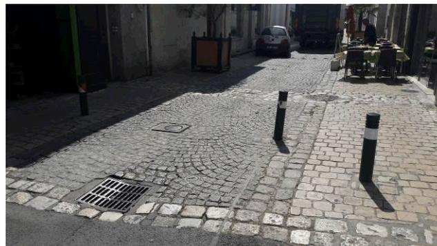
Une grille avec fentes > à 2 cm de large et 3 potelets non conformes à l'abaque de détection
