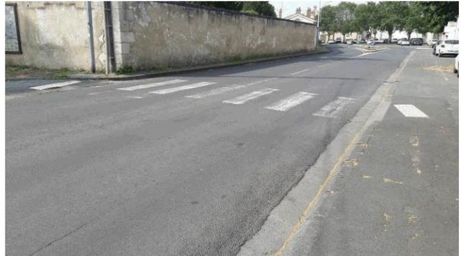
Bandes podotactiles non parallèle à la traversée de voie, non équipée d'un guide tactile
