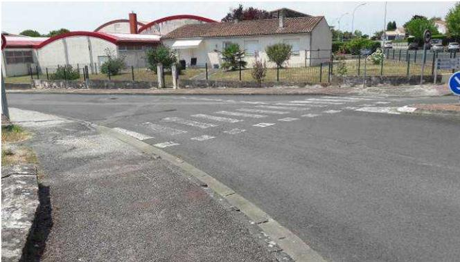
Traversée de voie sans bandes podotactiles, cheminement meuble avec pente > à 8% sur un côté
