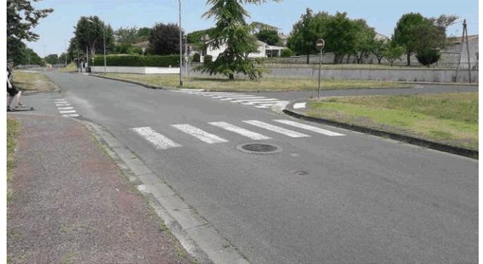
Une traversée sans abaissés ni bandes podotactiles, l'autre avec bande podotactile non parallèle à la traversée sans guide tactile
