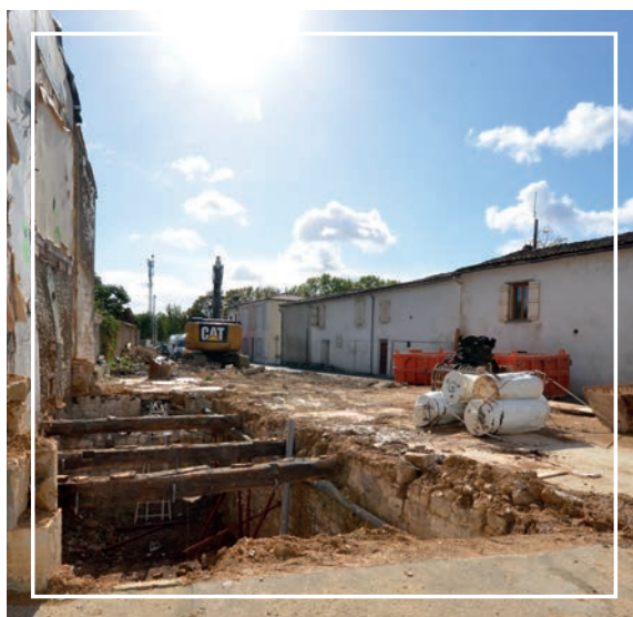
Rue du Palais : Démolition de la dernière maison. Le champ de foire s'ouvre vers le coeur de Ville.
