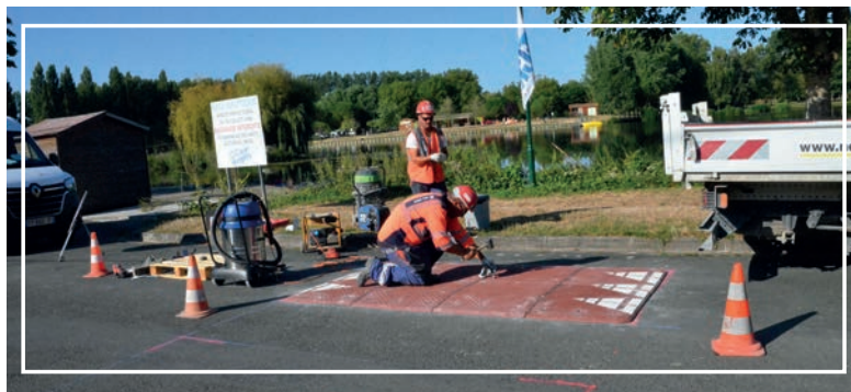
Quai de Bernouët : Installation de deux coussins berlinois en caoutchouc recyclé devant le club de kayak.
