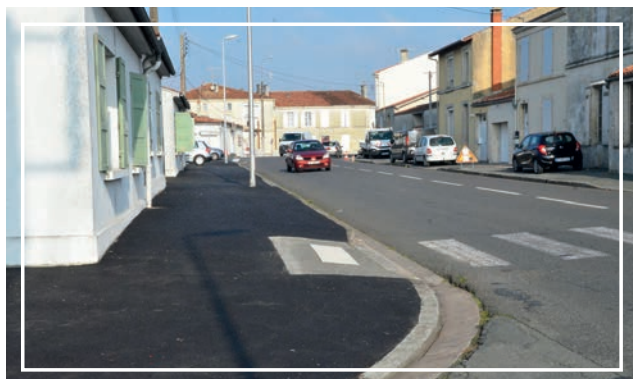
Boulevard du 14-Juillet : Réfection des trottoirs
