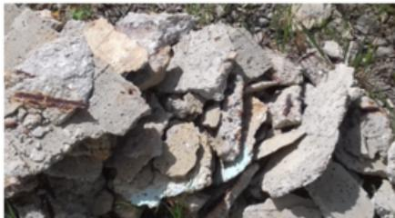
Chutes de blocs béton : dégradation du génie civil : extérieur cuve et intérieur cuve
