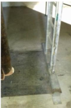
fixer l'échelle sur un support métallique qui repose de part et d'autre sur la dalle béton (voir réservoir 1500 m3 – photo)
