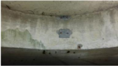
mauvais état du béton : ferrailage apparent
