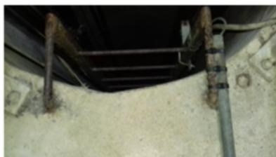
échelle **TRES corrodée** au niveau de sa fixation sur la plateforme béton de la cuve **DANGER**
