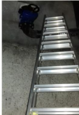
mettre une échelle fixe avec crinoline pour accéder à la place, vanne de vidange – supprimer l'échelle « mobile »
