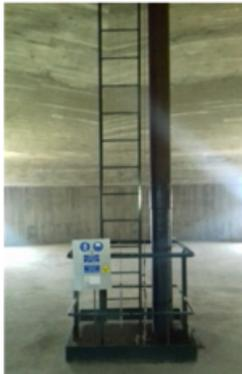
échelle d'accès à la plateforme de la cuve posée sur la trappe : **non sécurisée**
