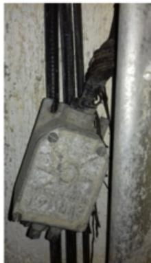
remplacer ou supprimer les câbles électriques situés à proximité de l'échelle **DANGER**
