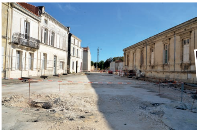
Rue du Palais : La réfection de la voirie se poursuit pour relier le champ de foire et la place de l'Hôtel-de-Ville.
