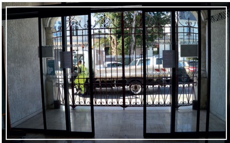
Salle Aliénor-d'Aquitaine : Le système de chauffage et une partie de l'éclairage ont été remplacés, le parquet a été rénové. Une porte automatique a été installée au niveau de l'entrée.
