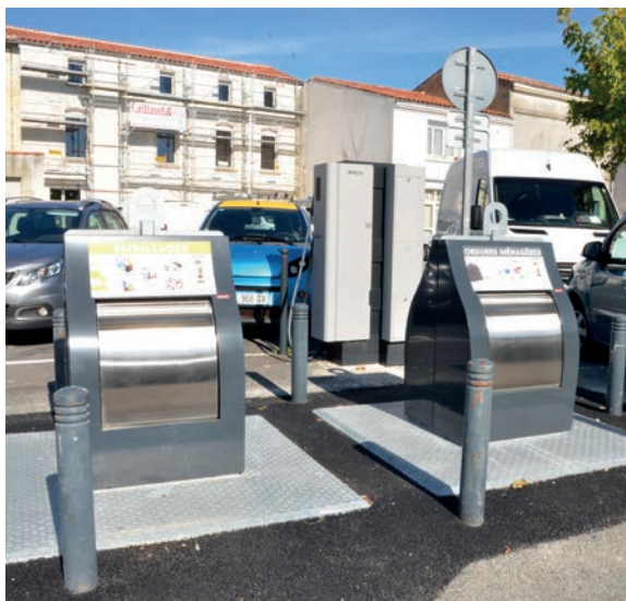
Ordures ménagères et emballages : Quatre points de collecte enterrés de 5m 3 ont été installés par Cyclad dans le centre afin d'améliorer la qualité du tri et de la collecte.
