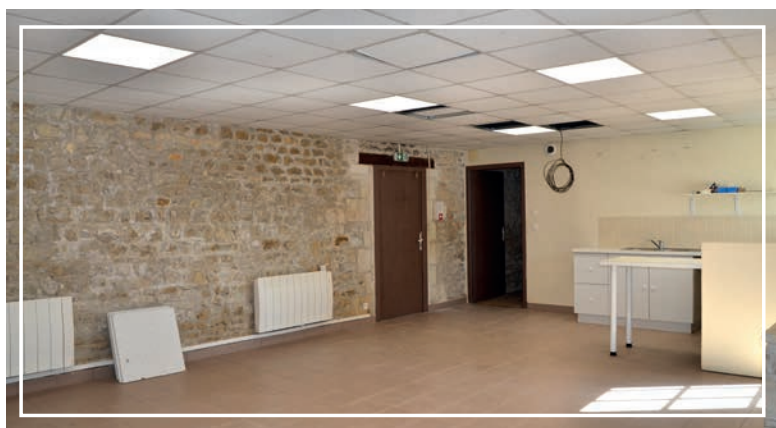
Maison du développement durable : Le rez-de chaussée de la maison de la pêche, quai de Bernouët, est en cours d'aménagement pour accueillir des associations qui oeuvrent pour le développement durable.
