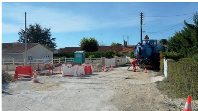
Cité Point-du-Jour : Réfection des eaux pluviales, des eaux usées et de l'eau potable.
