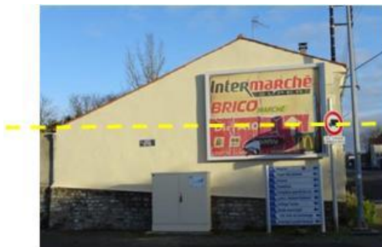
Surface et égout du toit
