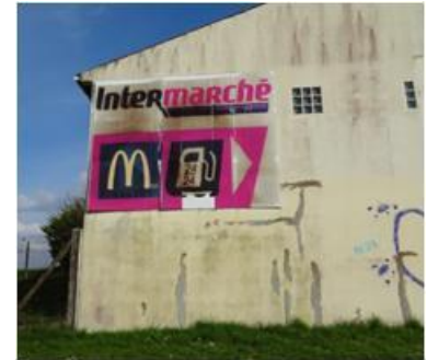
Surface et mauvais état
