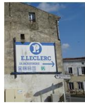
Surface, mur non aveugle, et mauvais état
