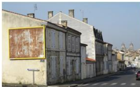
Pas d'information sur l'exploitant et mauvais état
