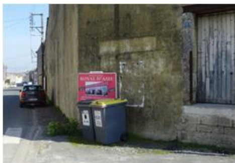
Installation sur mur non aveugle
