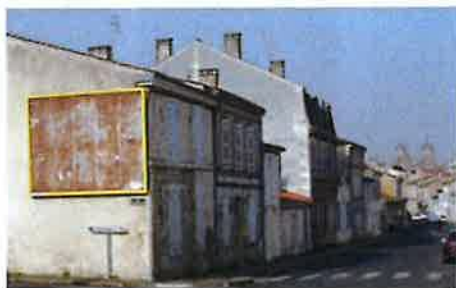
Pas d'information sur l'exploitant et mauvais état
