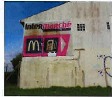
Surface et mauvais état
