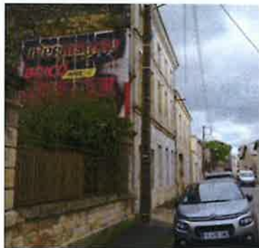
Autres infractions : surface trop importante et mauvais état
