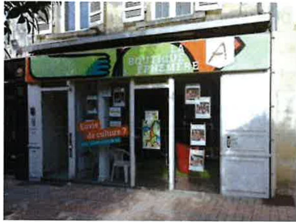
Enseigne débordant sur la porte d'accès à l'étage
