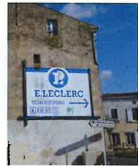
Surface, mur non aveugle, et mauvais état
