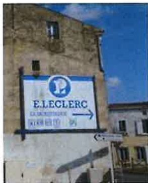
Mur non aveugle, surface non conforme, et mauvais état
